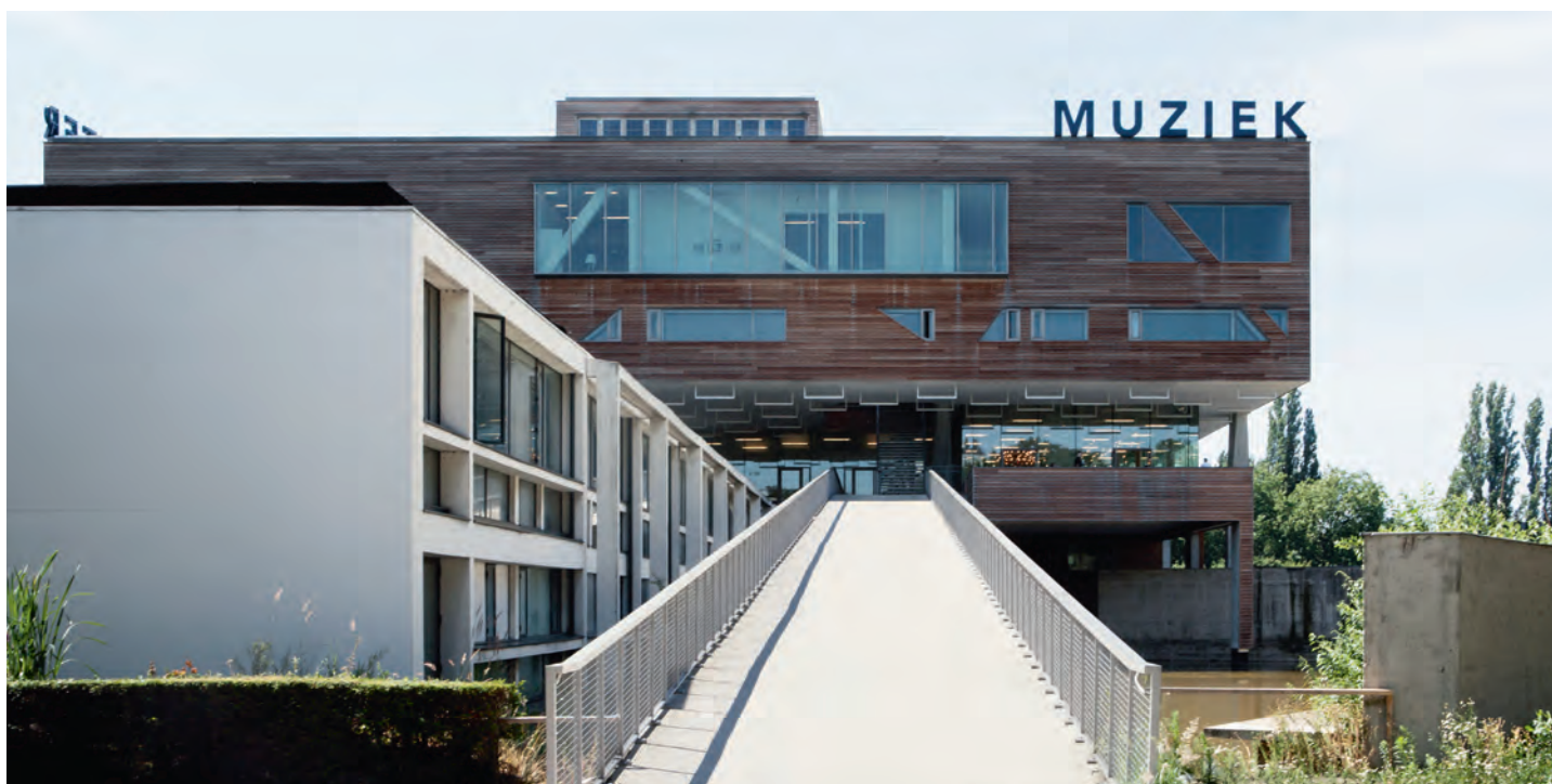
Extension de Singel Campus des Arts International, Anvers, architecte Stefaan Beel Architect bvba, Techniques Ingenium NV, copyright Luca Beel
